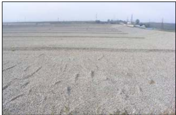
Figură 1. Incinta de depozitare – compartimentul 1
