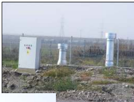
Figură 2. Stație de colectare a biogazului
